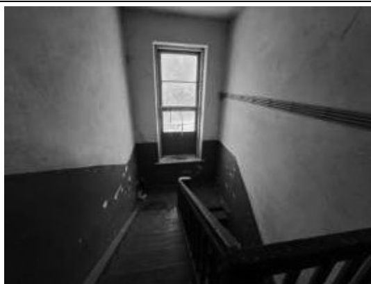
2.stāva kāpņu telpa
