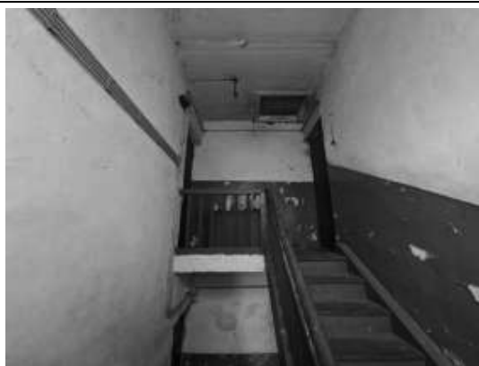
2.stāva kāpņu telpa
